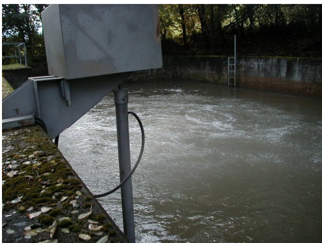
BGU-Svingstrålerøret laver bevægelse og forhindre forrådnelse i bassinet
