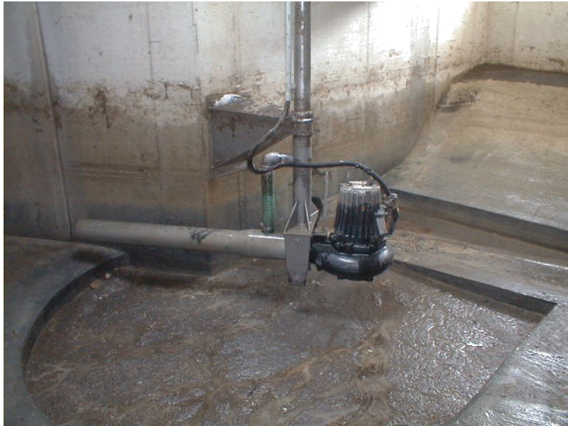
Installeret Svingende Jetstrålerør
